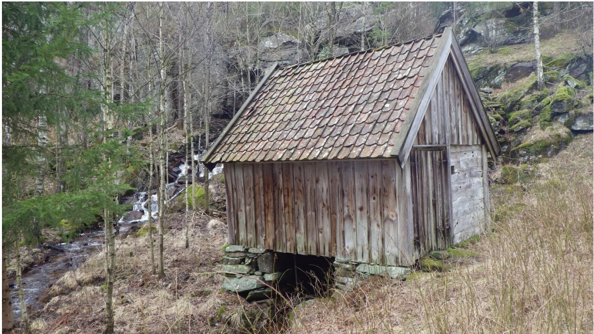
Skvaltkvarn nr 2, bakom kvarnen är det höga branta fallet ovanför vilket Store Dämm är belägen
