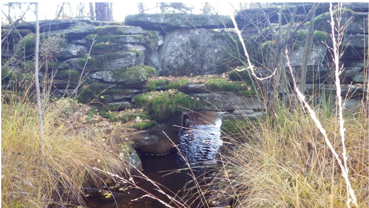
Övre fördämningen, nedströmssidan
